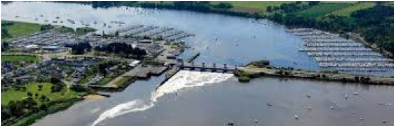
Barrage d'arzal, ports de plaisance rive Camöel et Arzal
